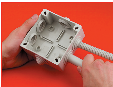
2 этап. Ввод гофрированной и жесткой трубы
